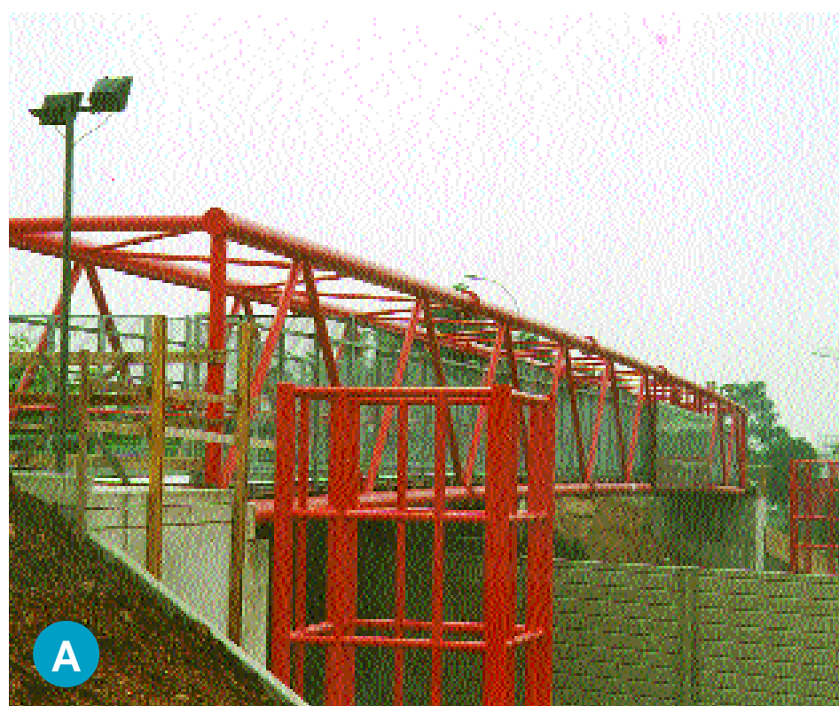
La nuova passerella pedonale sull'autostrada Milano-Laghi
